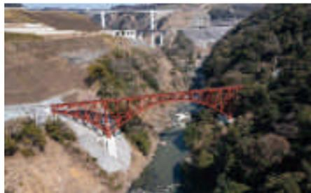
1927年に完成し、先人たちの貴重な建設技術とその優れた景観美から土木学会選奨土木遺産にも選出された第一白川橋梁は、地震の影響で右岸と左岸の両側から橋の中心方向に力がかかり、そり上がりなど異常な変形が生じました。複数の部材が損傷を受けており、架替えによる復旧が計画されました。新しい橋は、耐震性能を向上させることはもとより、旧橋の構造形式・部材の断面寸法・色を踏襲し、震災前の景観美を復活させることをコンセプトとして設計され、工事が進められました。第一白川橋梁は、2022年度の土木学会賞\*田中賞[作品部門]を受賞しました。
